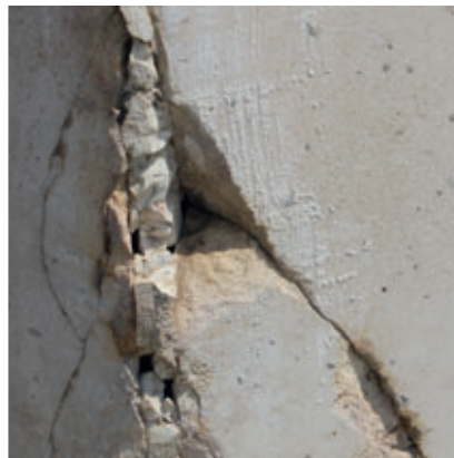
[F. 10] Izquierda, detalle de concreciones de sales. Derecha, eflorescencia desarrollada.
