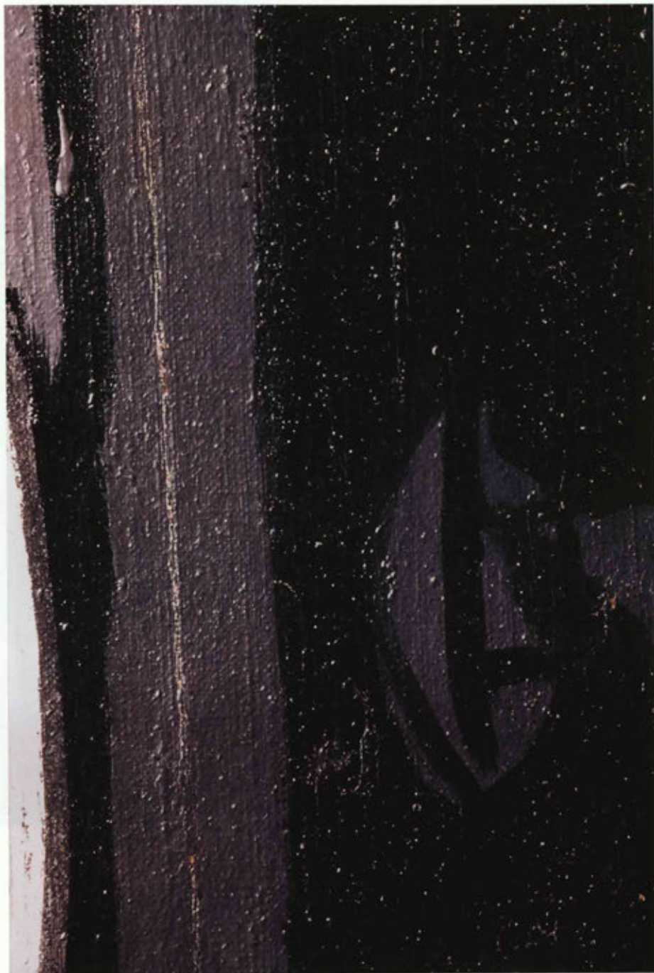
57 (C-14) Grietas en sentido vertical. Microfisuras. Pérdidas.
