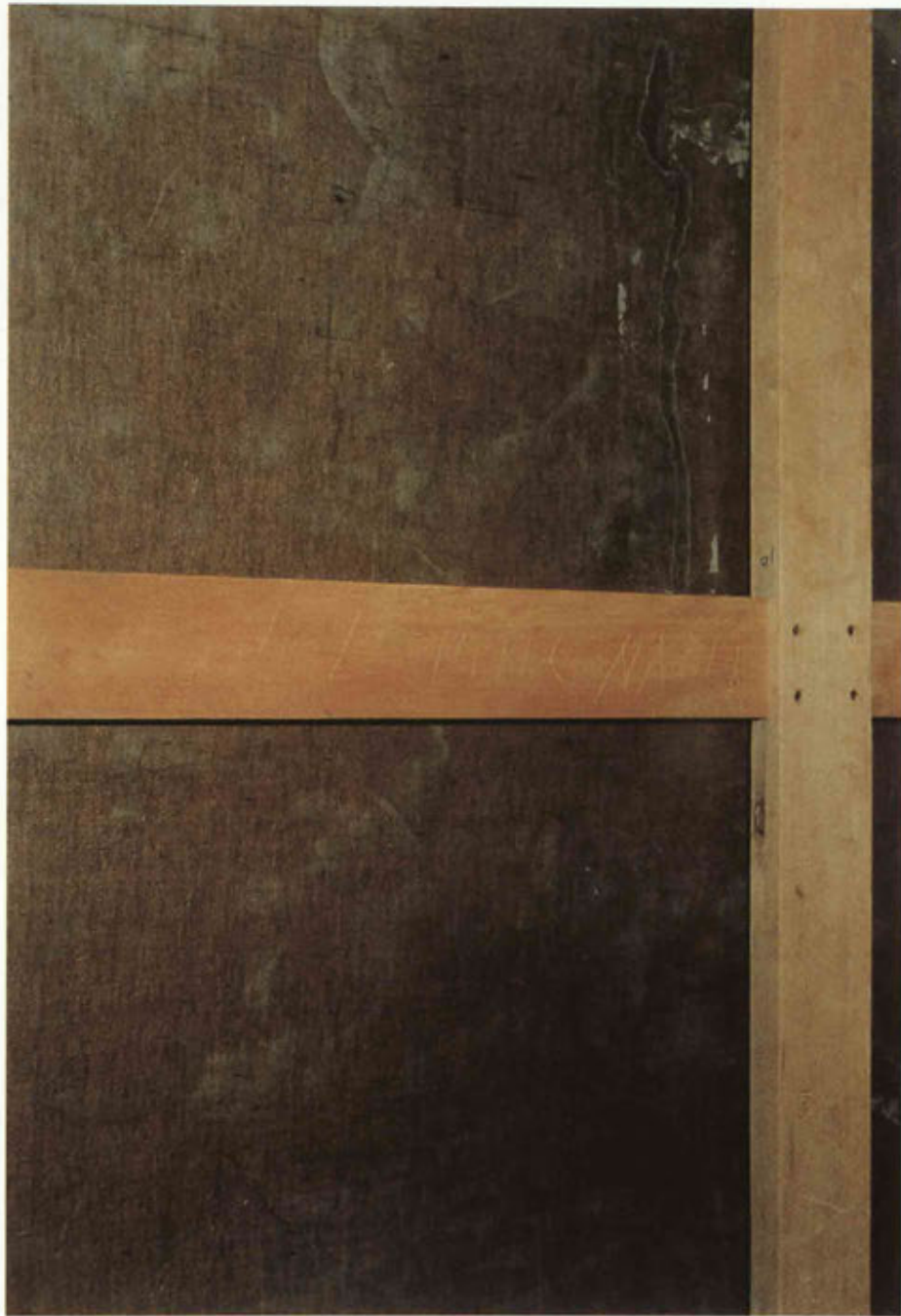
9. Desgarros con refuerzo y acumulaciones de cera-resina.
