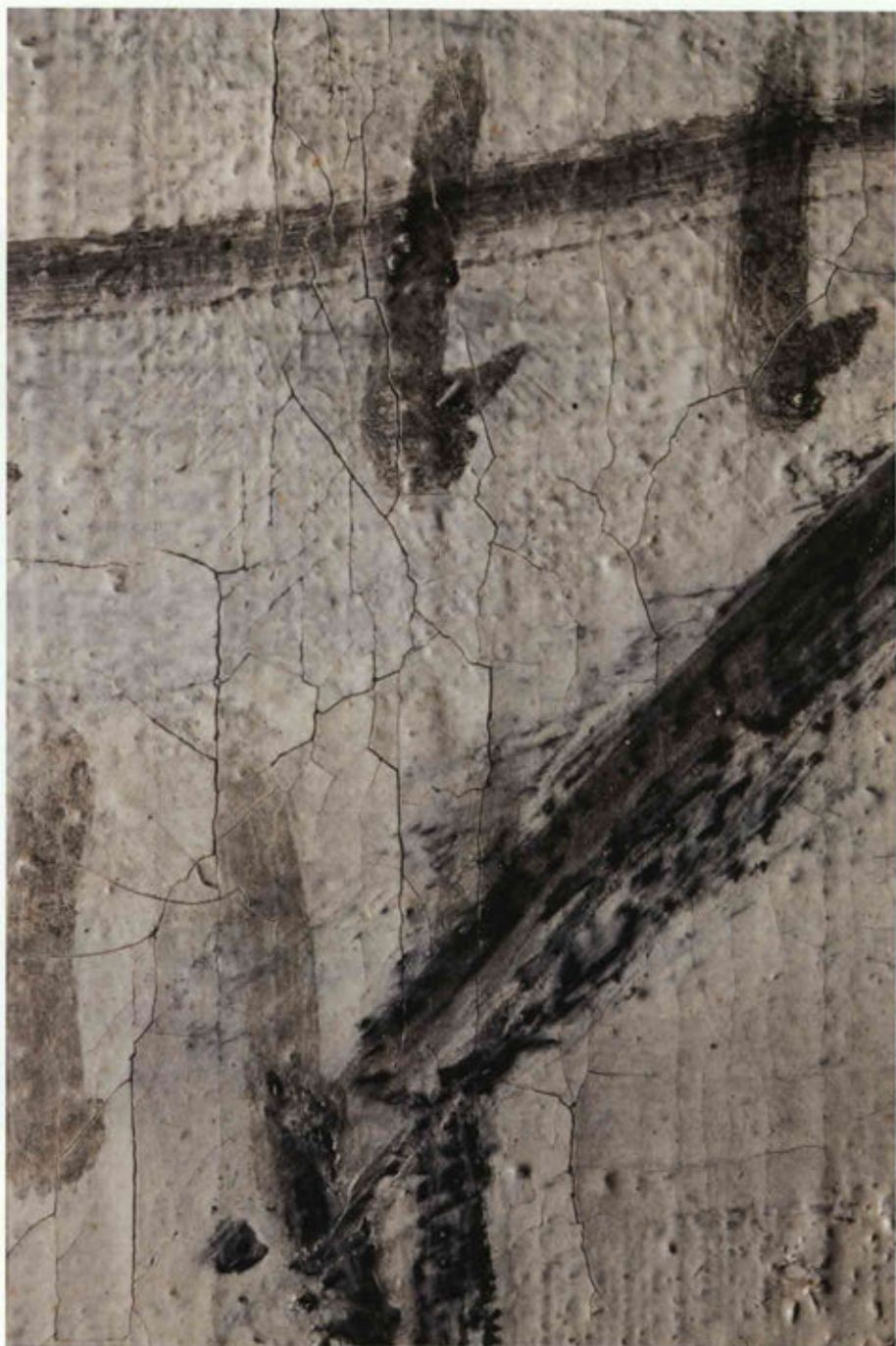
71 (D-6) Craqueladuras. Microfisuras.
