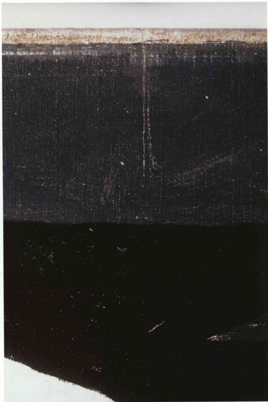
9 (A-6) Grieta (sentido vertical). Desgastes.
