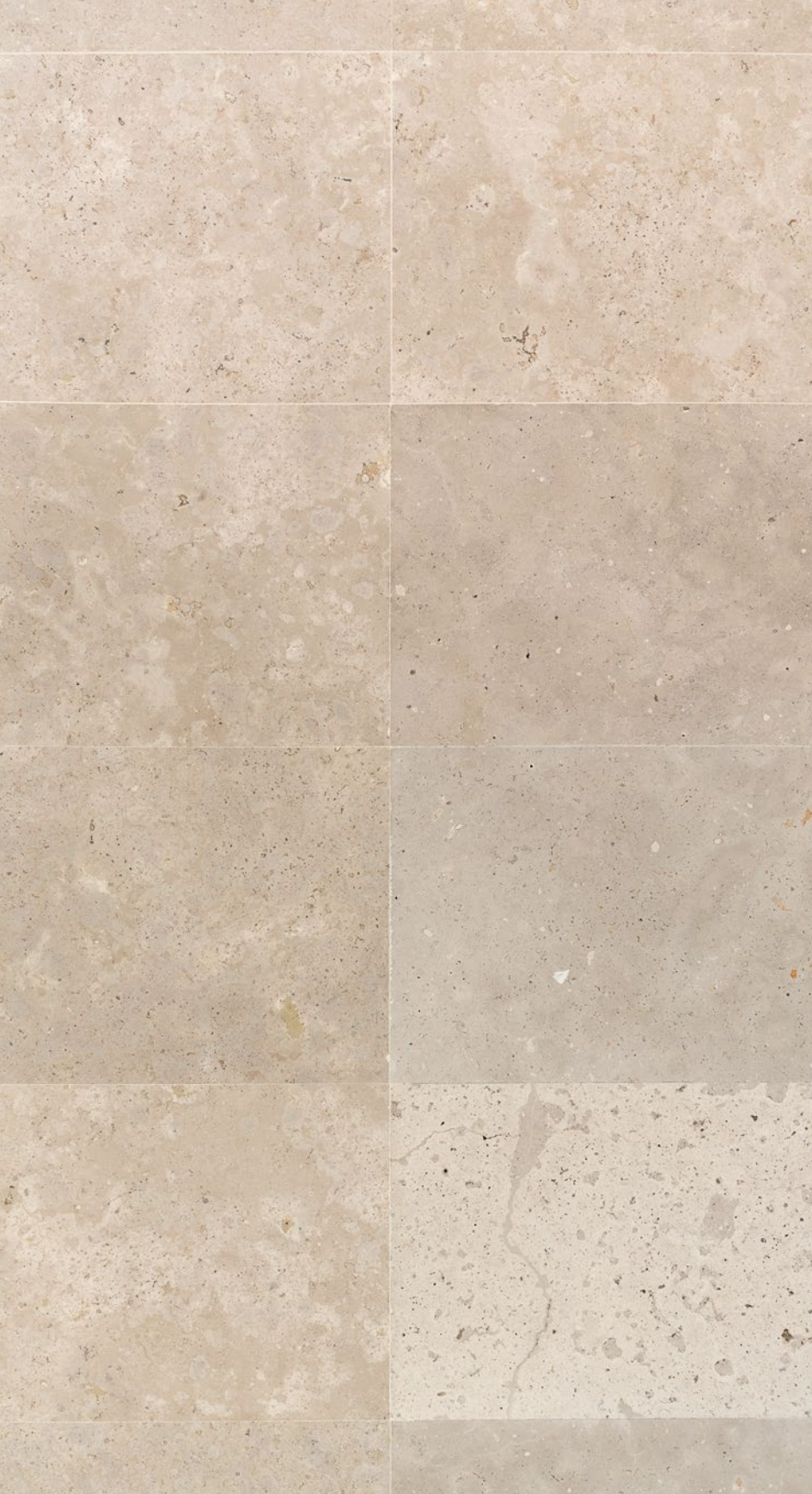
Panel acabado en piedra. Piso 5, Edificio Sabatini
