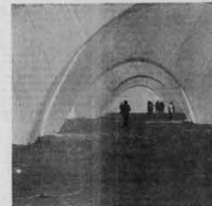
Interior de las cúpulas neumáticas, cuya altura individual alcanza a tener un diámetro de 25 metros. — (Foto ZUBETA).
