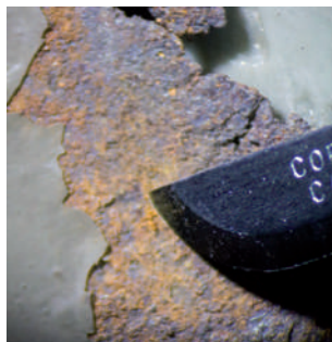
[F. 06] Detalle de la retirada de la corrosión del soporte con bisturí.
